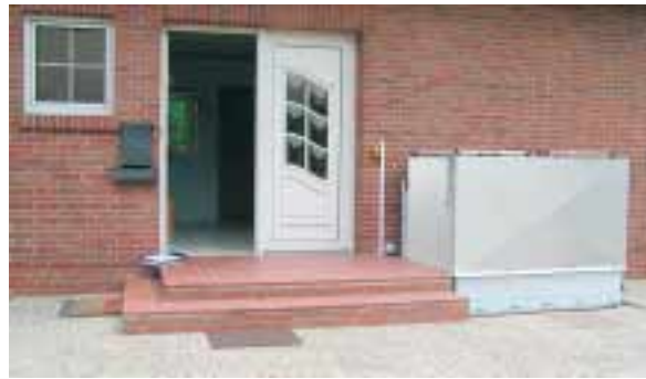
Da die Grundstücksgrenzen eine schräge Auffahrt nicht zuließen, wurde hier ein elektrischer Hublift gewählt. Dieser ist von Rollstuhlfahrern eigenhändig zu bedienen und ermöglicht somit, das Haus ohne Fremdhilfe zu verlassen.
