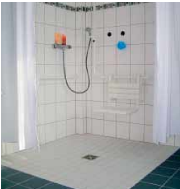
Nach diesem Umbau ist es einem Rollstuhlfahrer eigenständig möglich, die Dusche zu befahren, so dass ohne bzw. mit möglichst wenig Fremdhilfe die Körperreinigung vorgenommen werden kann.
